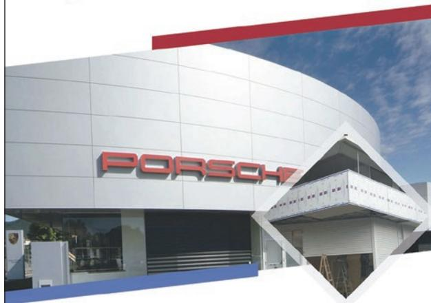
El panel de aluminio compuesto se compone de dos láminas y un núcleo central de polietileno. Su estructura combina ligereza y alta resistencia a la rotura, por lo que se manipula con gran facilidad.
